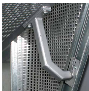
Torkonstruktion ausgelegt auf 500.000 Bewegungen
